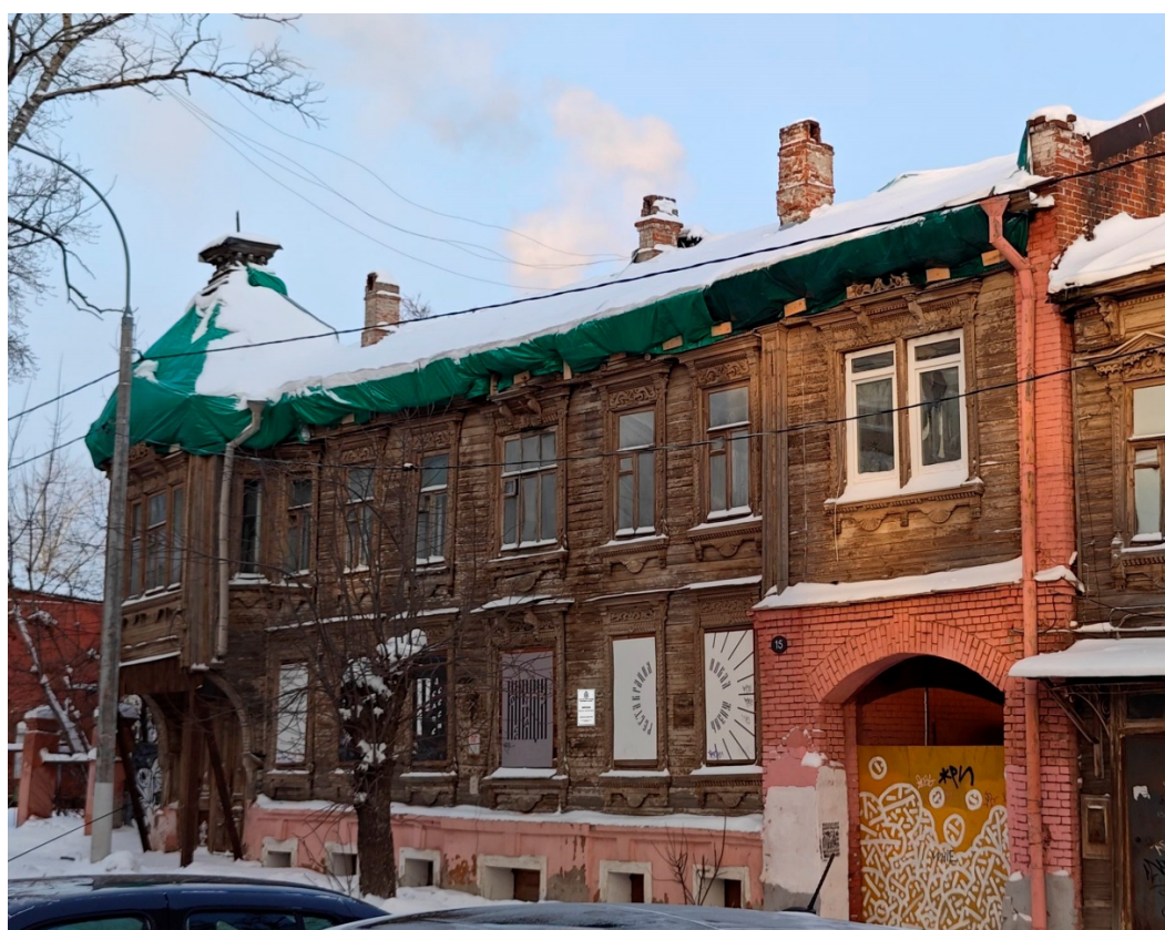
Предполагаемое место установки информационной надписи на главном (южном) фасаде объекта культурного наследия регионального значения «Жилой дом» (фотомонтаж).
